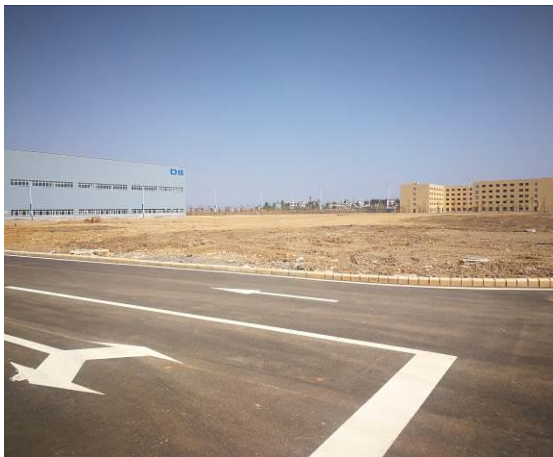
5-6#厂房预留区域现状
