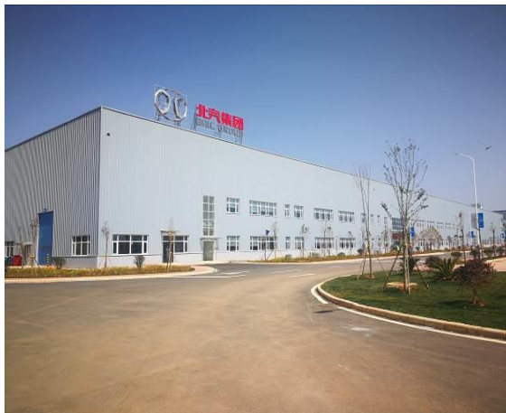
建构物区现状（一）
