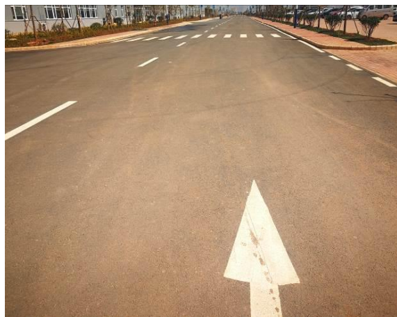
道路硬化区现状（一）
